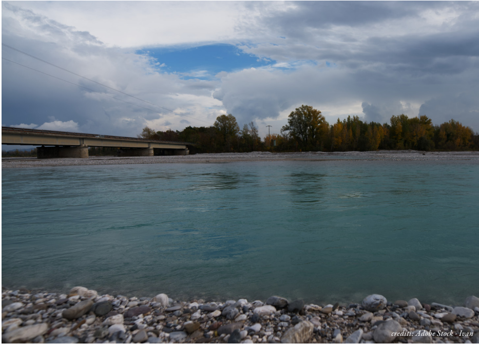
Il ponte di Cimano.
